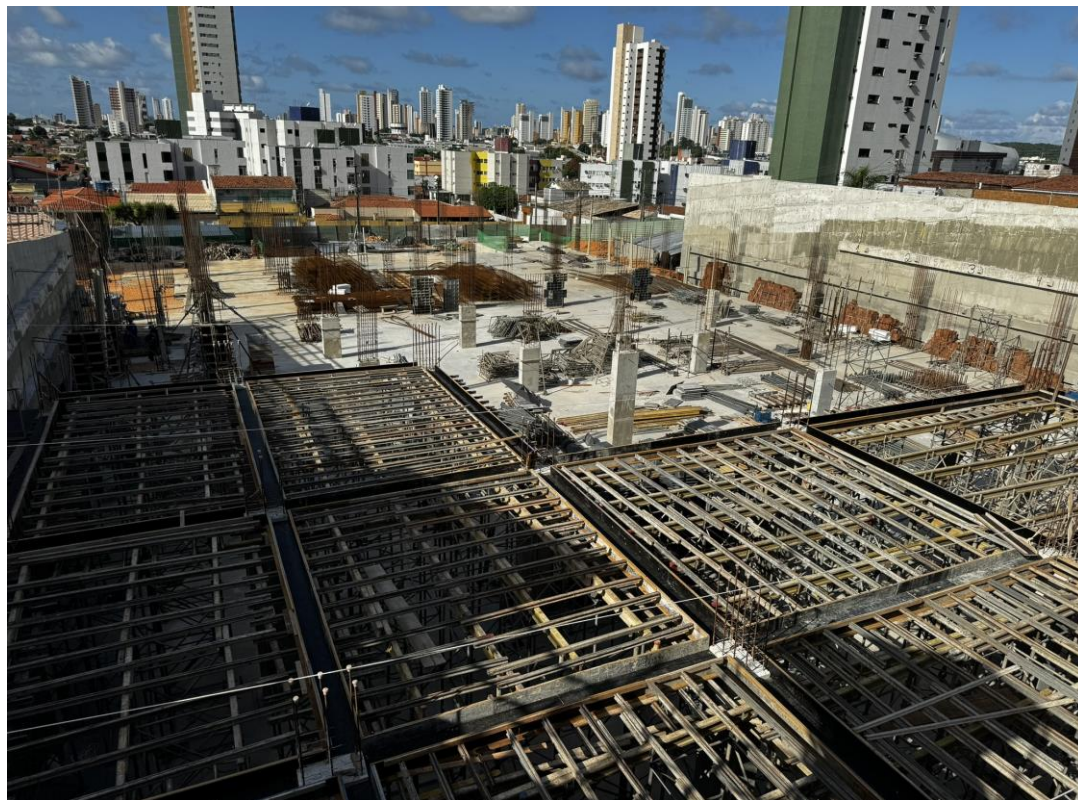
Figura 1. Visão geral da obra.
