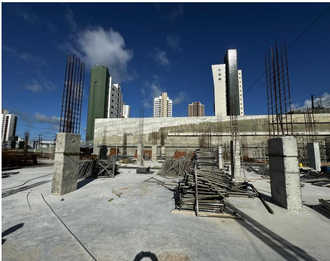
Figura 6. Pilares concretados no segundo subsolo.
