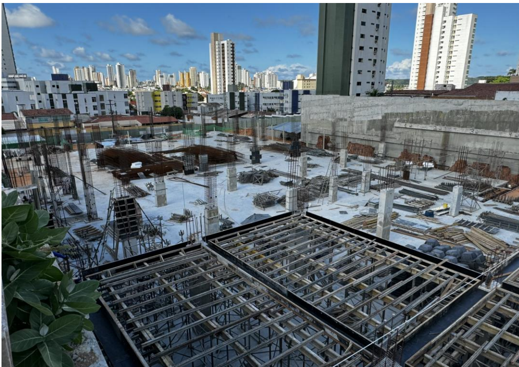
Figura 8. Visão geral dos pilares concretados e com a armação esperando as formas.
