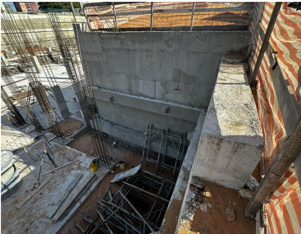
Figura 2. Trecho 1-E após concretagem da última viga.
