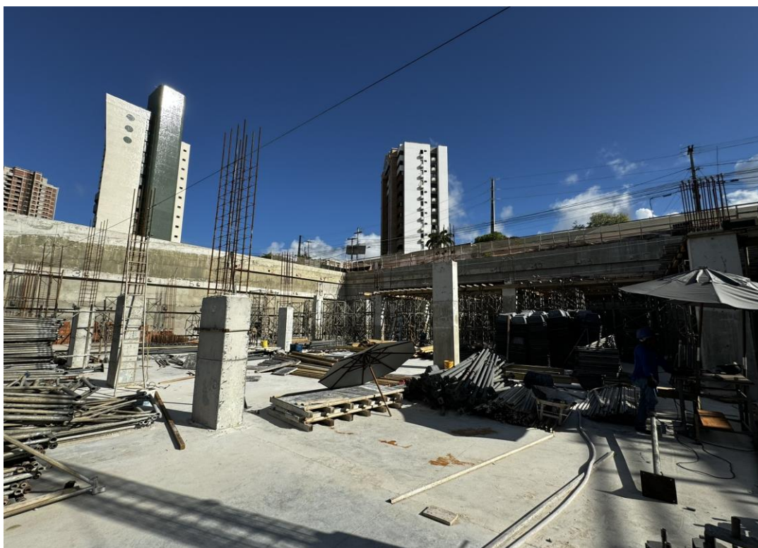
Figura 7. Pilares concretados no segundo subsolo.
