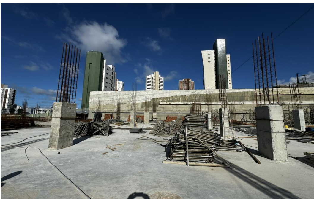
Figura 9. Aplicação da argamassa polimérica nos paredões da contenção.
