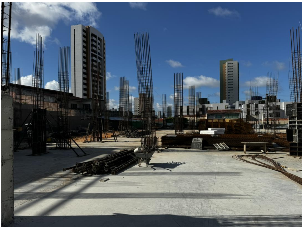
Figura 4. Laje de piso do segundo subsolo.
